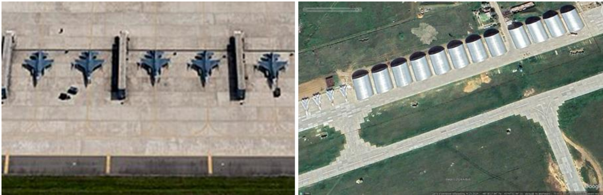
Hava araçlarını koruma maksath inşa edilen patlama duvarları
